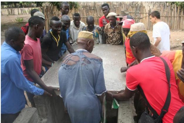
couler les dalles directement sur la latrine (solution impraticable durant ce voyage en raison du temps et du coffrage compliqué), ou faire des dalles plus minces (ce qui pose problème pour la solidité de l'édifice). L'enduit à l'intérieur des fosses a également été réalisé.
